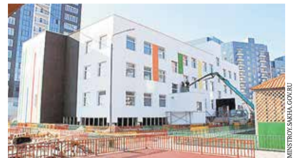
Строительство Центра детского творчества в Якутске
